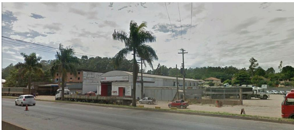
Figura 3-6 - Rodovia 262, Bairro Parque Industrial, Viana-ES.
