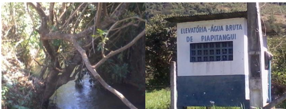
Figura 3-56 - Manancial de captação e Estação Elevatória de Água Bruta (EEAB).
