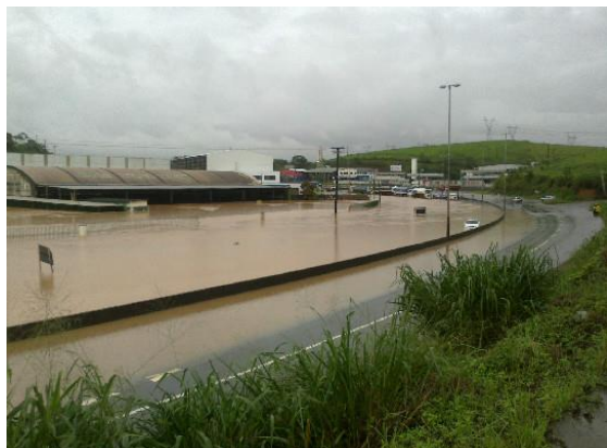
Figura 3-18 - Alagamento na BR 262, Viana-ES.
