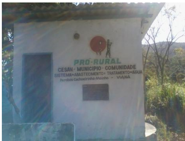
Figura 3-55 - Instalações do Pró-Rural de Perobas.
