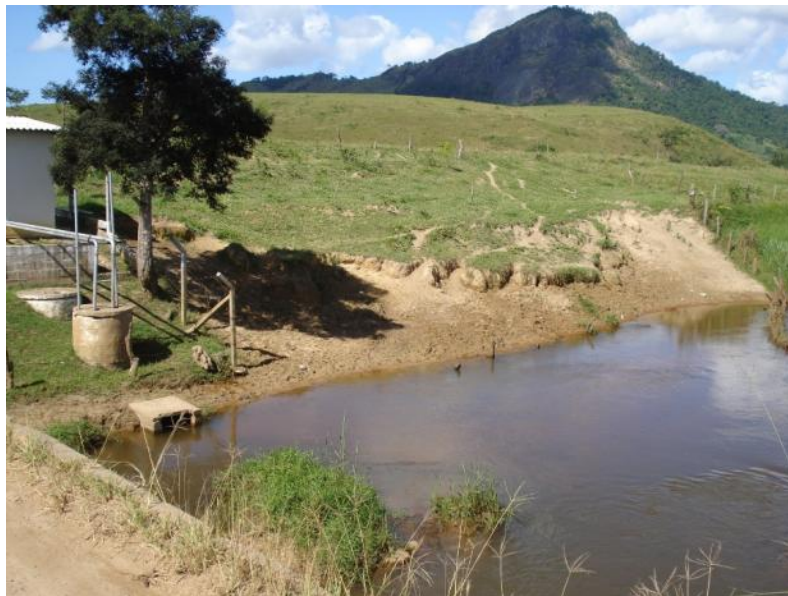
Figura 3-49 - Captação de água bruta no Rio Jacarandá.
