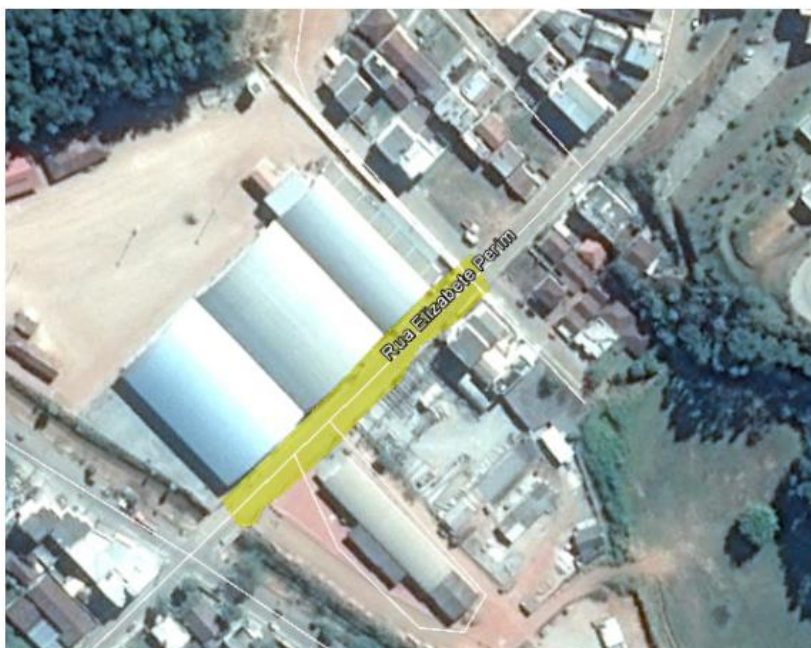
Figura 3-36 - Assoreamento na galeria pluvial, Bairro São Rafael.
