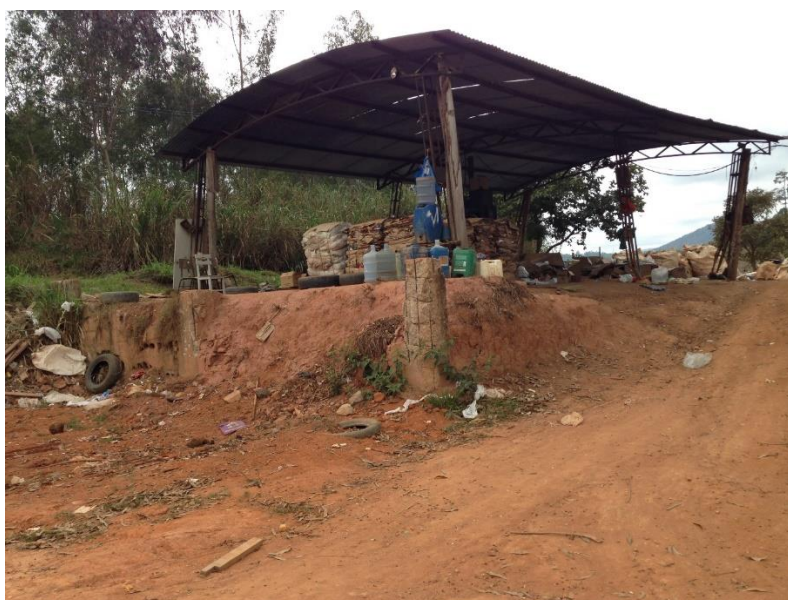
Figura 3-48 - Galpão de triagem.
