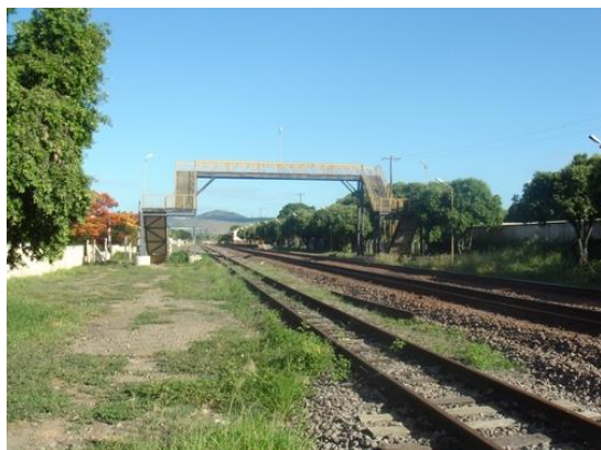
Figura 3-3 - Ferrovia Vitória Minas. Baixo Guandu-ES.
