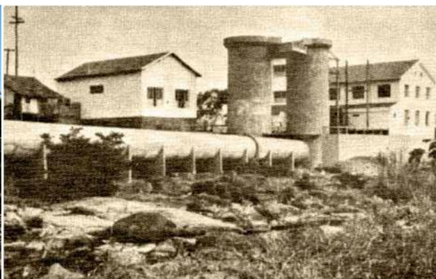
Figura 3-4 - Usina Hidrelétrica Von Lutzow, Baixo Guandu-ES.
