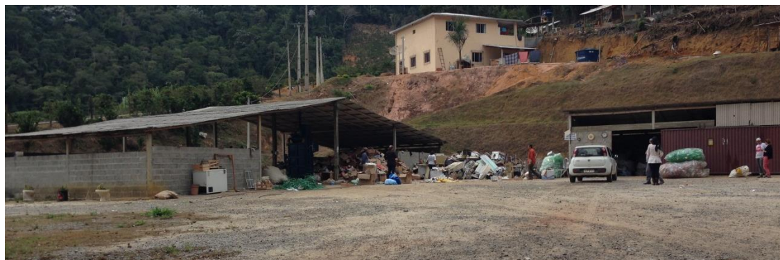
Figura 4-28 - Galpão de Triagem.
