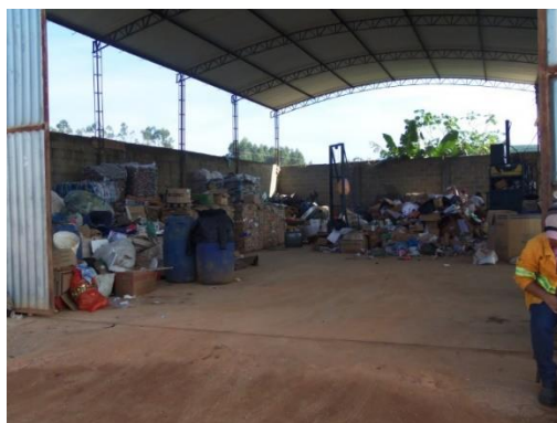
Figura 4-27 - Galpão de Triagem da associação.
