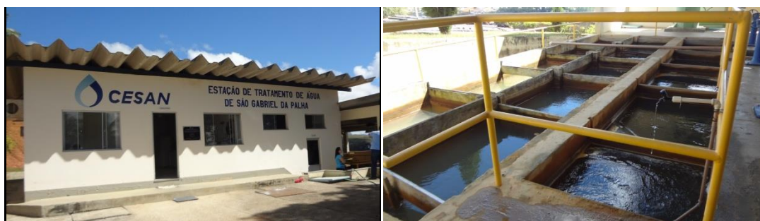
Figura 3-22: Estação de Tratamento de Água de São Gabriel da Palha.
