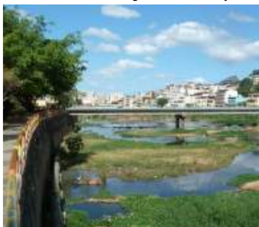
Figura 5-6 - Situação de alguns trechos do rio Itapemirim.
