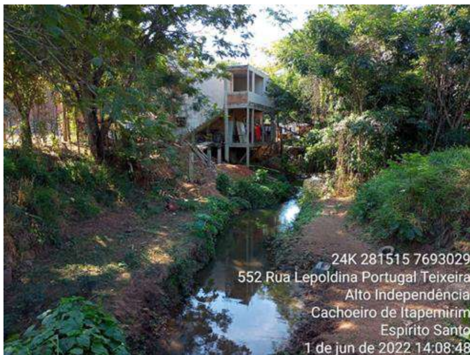
Figura 2-60 - Edificação construída adentrando o leito do córrego Monte Líbano, afluente córrego Cobiça.
