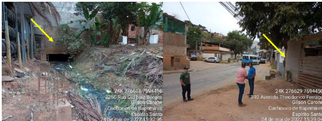
Figura 2-28 - Córrego Gilson Carone as setas amarelas indicam construções sobre seu caminhamento principal. Neste trecho, a PMC já teve que demolir piso residencial para realizar manutenção na calha do Córrego.
