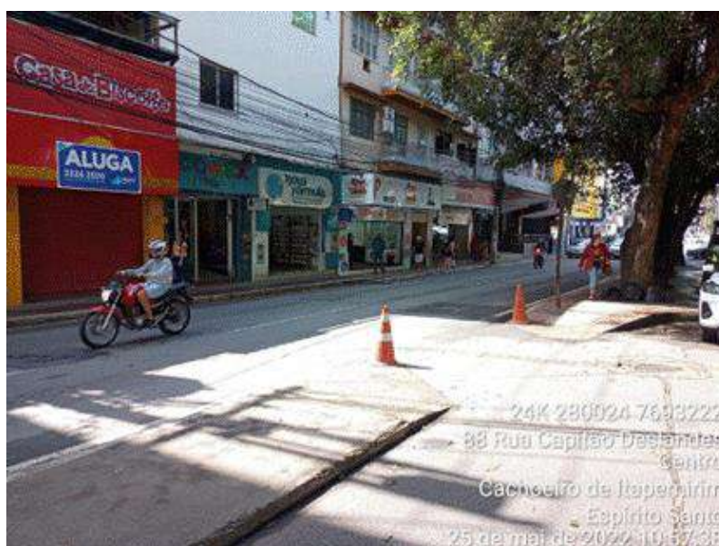
Figura 2-65 - Praça Jerônimo Monteiro: As águas pluviais da Praça escoam para este local, porém a falta de captação das águas a montante tem causado os alagamentos.
