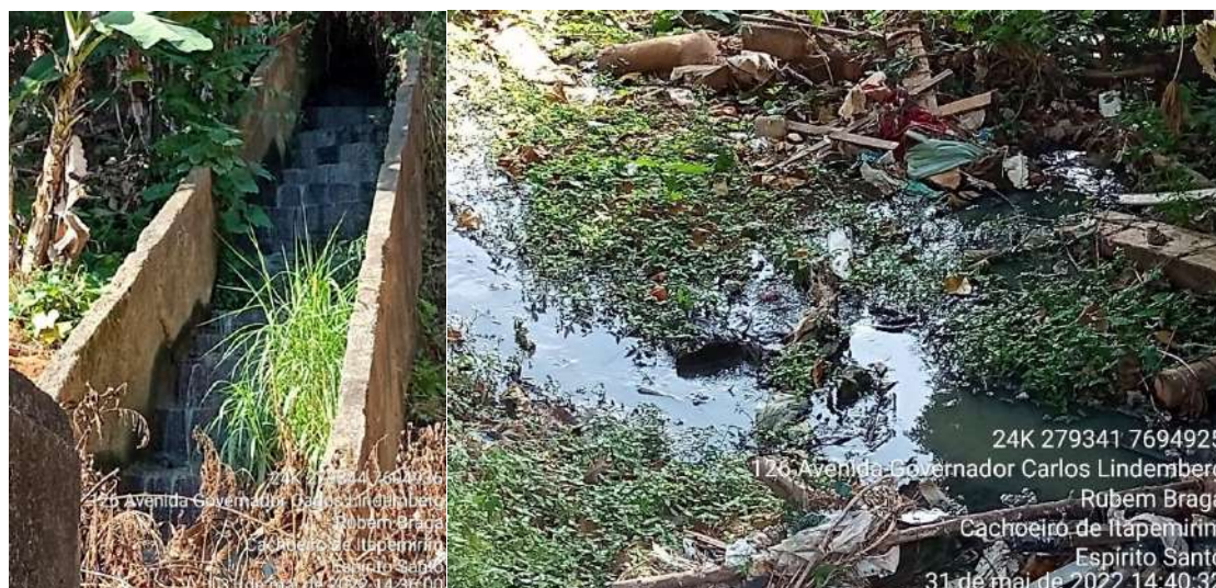
Figura 2-43 - Bacia Fé e Raça. Escada hidráulica de águas pluviais com fluxo constante de esgotos. Foz da Bacia com esgotos nas águas.
