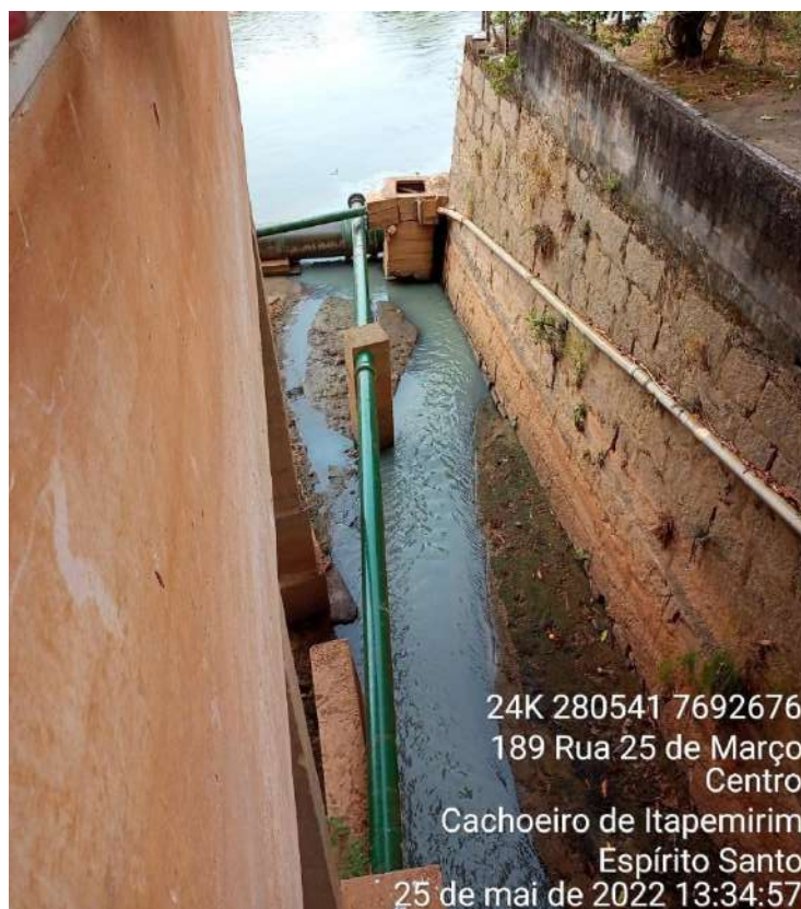
Figura 2-33 - Bacia Amarelo. Trecho final da foz demonstrando esgotos nas águas. Em trecho urbano do córrego Amarelo foi visualizado esgotos nas águas.
