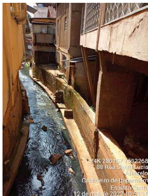
Figura 2-59 - Edificações muito próximas estrangulam a seção de escoamento do córrego Amarelo.
