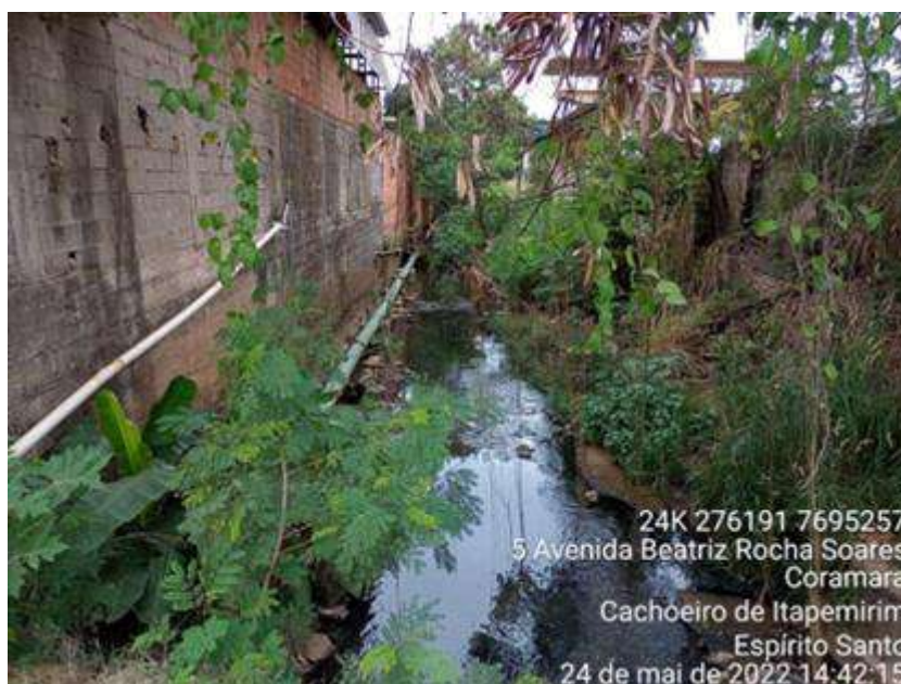
Figura 2-58 - Destaque de seção restringida pela ocupação urbana no córrego Coramara.
