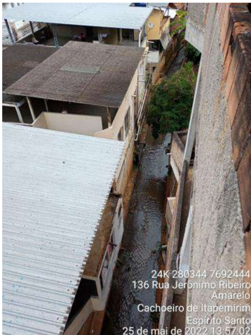
Figura 2-27 - Córrego Amarelo completamente confinando entre muros e casas.
