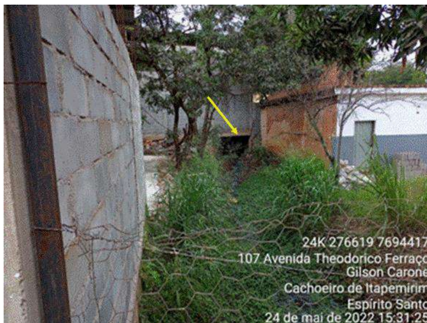
Figura 2-57 - Córrego Gilson Carone (a seta indica caminhamento sob galpão).
