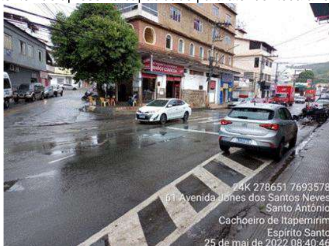
Figura 2-64 - As ruas adjacentes, mais altas, escoam as águas pluviais para este ponto. A rede existente não apresenta capacidade para atender toda a região.
