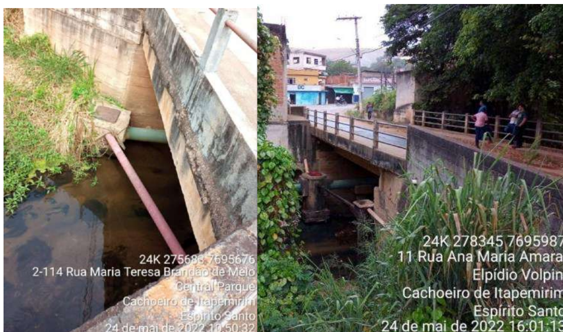
Figura 2-38 - Bacia Valão. Calha principal, em Central Parque e em Elpídio Volpini, sendo atravessado por canalizações de esgoto
